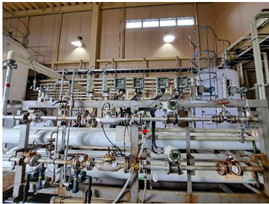
圖2-55 佐渡深層海水滲透膜設備監測器
