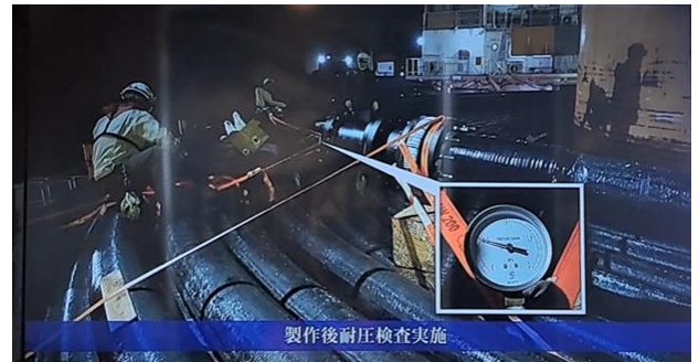
圖3-2 日本製作取水管線後耐壓測試
