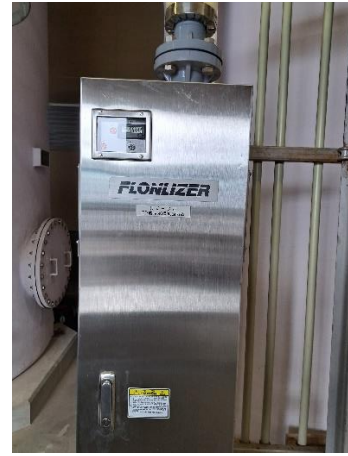
圖2-60 佐渡深層水ED脫鹽水槽滅菌裝置
