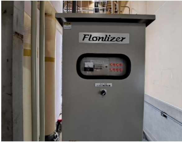
圖2-59 佐渡深層水RO淡水槽滅菌裝置
