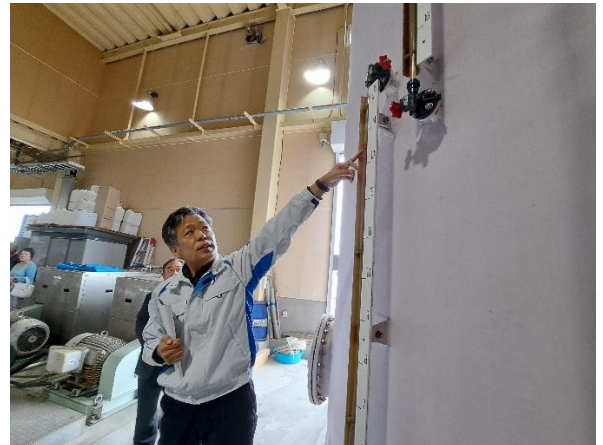
圖2-58 佐渡深層水製水桶槽水位顯示
