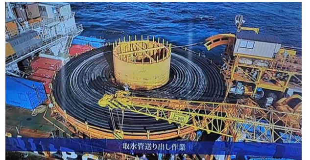
圖3-4 日本鋪設入善取水管線海上作業
