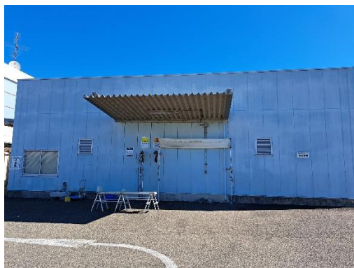
圖2-82 駿河灣深層水大量取水管線
