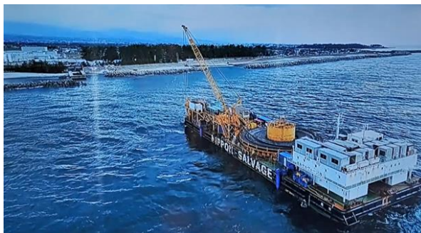
圖3-3 日本入善取水管線鋪設船
