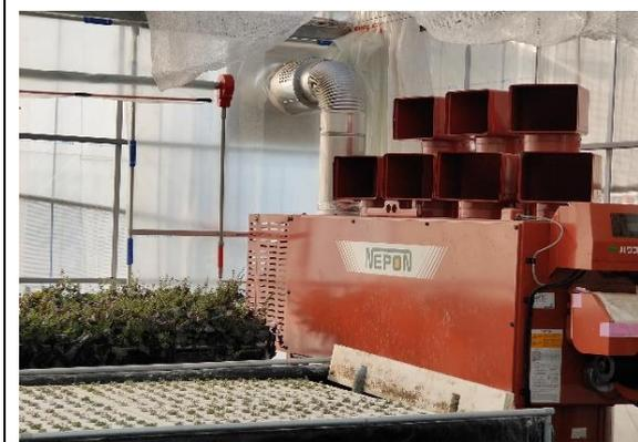
圖 6-7、NEPON 熱泵加熱系統
