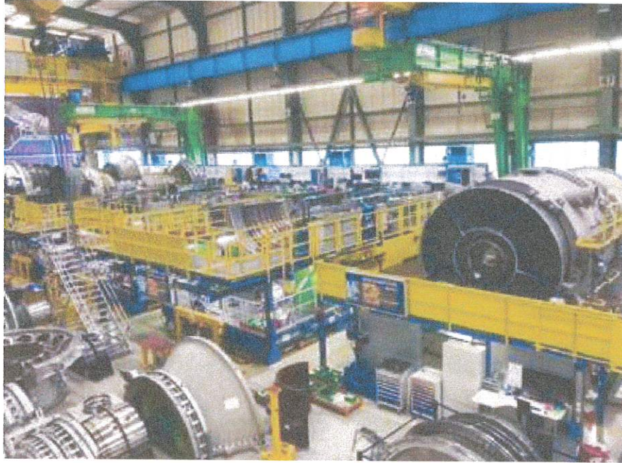
圖 5: GT 組裝測試平台
