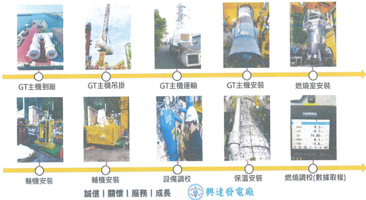
圖 10：興達氣渦輪機Repowering 改善過程
