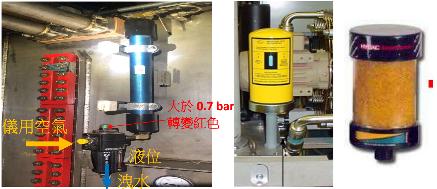
圖12.11 油槽乾燥及過濾裝置
