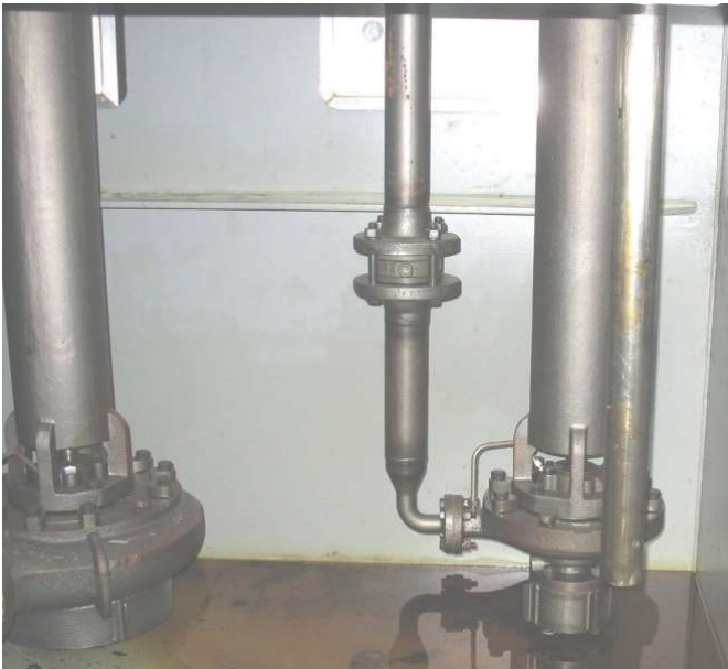
圖11.15 離心式封油泵示意圖
