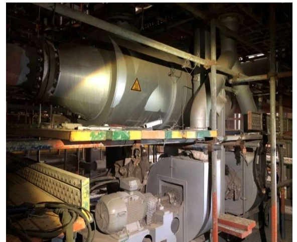
圖8.5格蘭蒸汽冷凝器示意圖
