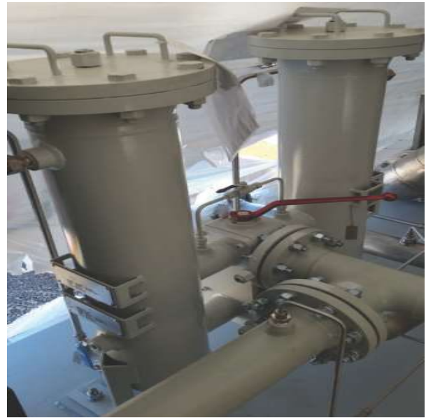
圖11.16 封油過濾器示意圖
