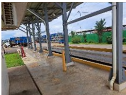
圖23、大型地磅可收集農場小區產量
