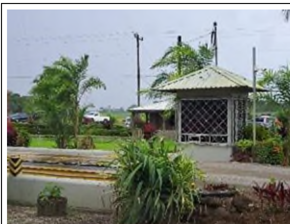
圖3、大型地磅可收集農場小區產量
