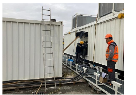
圖 19、原廠技師正在連接發電機與電控室
