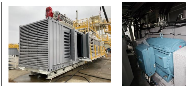
圖 11~12、液壓動力單元已完成內部組裝
