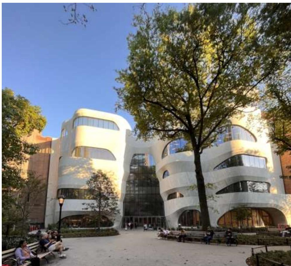
進入吉爾德中心後，是一個 5 層樓高的中庭，底端有一座大大的階梯，讓大家可以自由的坐下來休息、聊天、飲食，自然光通過大型天窗進入，據說建築紋理、顏色和流動形式的靈感來自美國西南部的峽谷，結構是無需傳統模板，將混凝土直接噴射到鋼筋上而建造的，這獨特的造型讓我們非常的驚豔。
