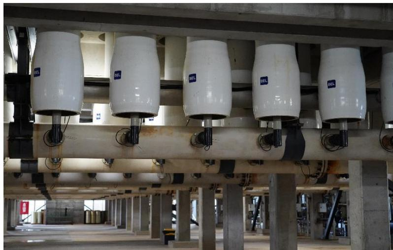
圖 26、廠區逆滲透圓柱設備裝置情形
