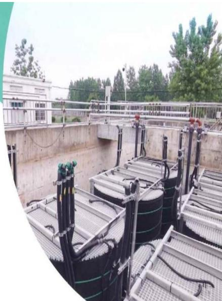
圖 34、安裝於厭氧消化槽中的 SUBRE 模組（資料來源：Fluence 公司提供資料節錄）
