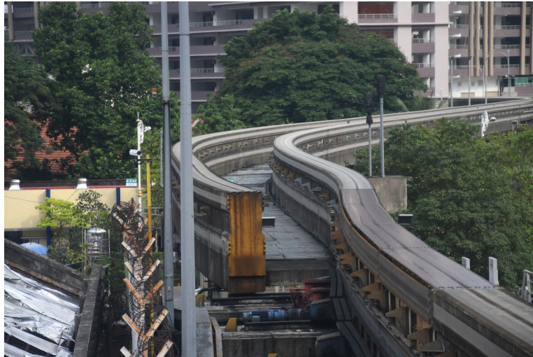
圖 2.15 單軌端點站的道岔設施
