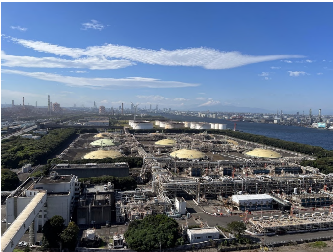
附圖 22、俯瞰 JERA 東扇尾發電廠的廠區範圍與環境林。
