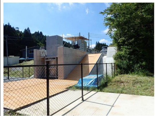
舊岩出山水力發電所址新建的小水力發電站。
