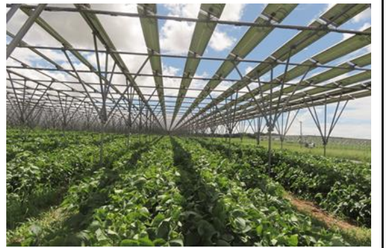
單列太陽能板投射的遮光陰影較細，市民能源株式會社設計的農電共生設施希望能盡量減少農業地景不適感。
