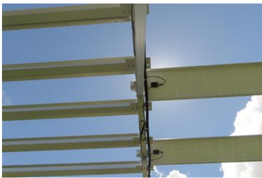
單列太陽能板示範區，右邊是傳統二列式太陽能板，左邊是由鈣鈦礦做成單列太陽能板。
