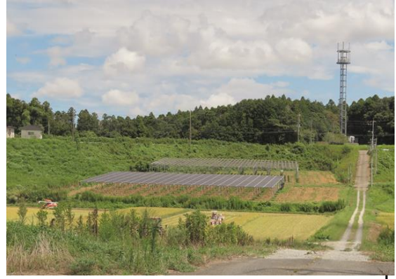
單列太陽能板投射的遮光陰影較細，市民能源株式會社設計的農電共生設施希望能盡量減少農業地景不適感。
