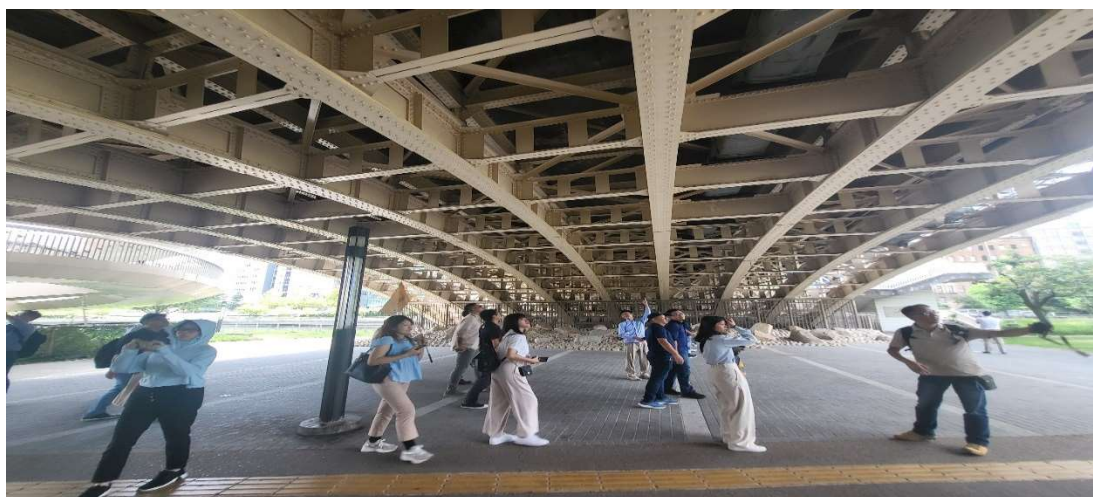
圖43 中之島公園百年橋梁天神橋結構考察
