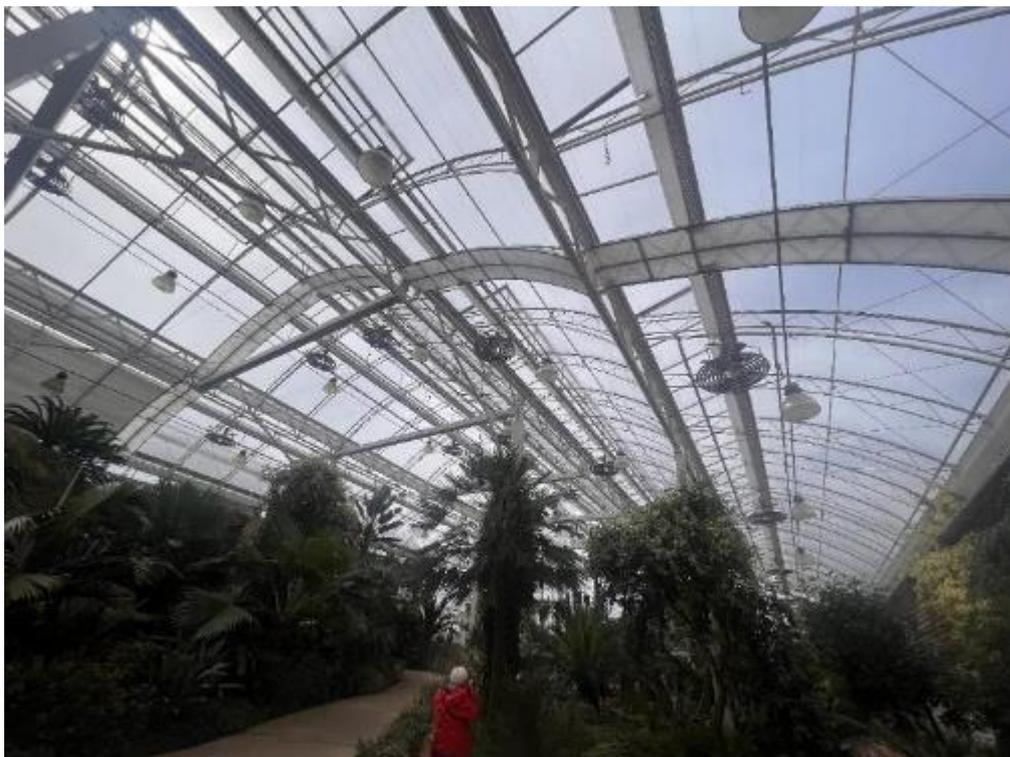
圖廿八、威斯利花園溫室加溫系統置於高處以風扇向下吹拂
