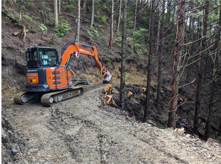
圖 2 作業道開設情形
