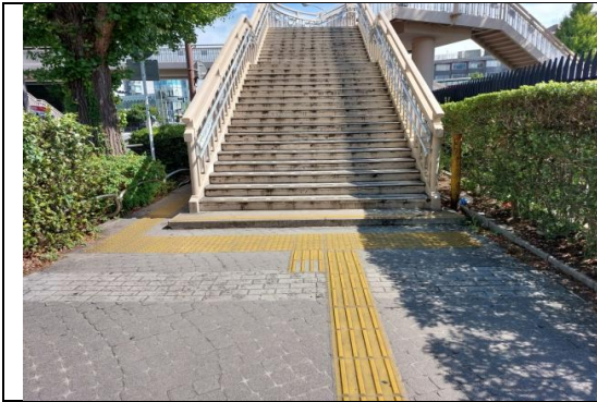
圖 5.通往人行陸橋設置導盲磚
