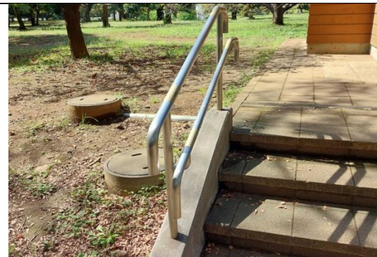
圖 28. 代代木公園無障礙廁所階梯設置扶手
