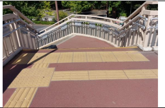
圖 6.人行陸橋上設置導盲磚
