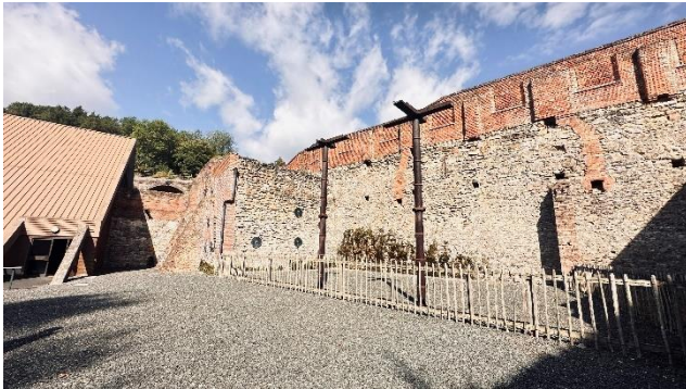
遺跡圍籬架設木板做為圍籬，以防止民眾進入。
