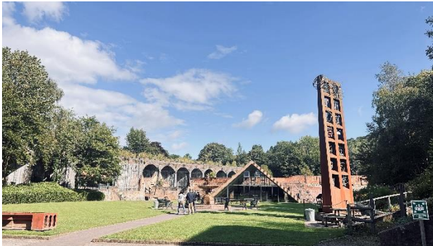
老熔爐遺跡外觀，搭建玻璃幃幕，防止遺跡塌陷之功用。
