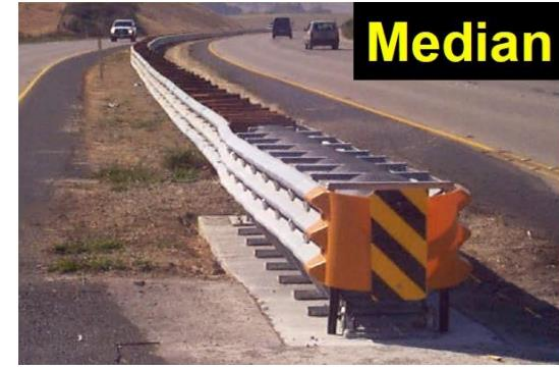
圖 3-19 護欄終端之緩撞設施
