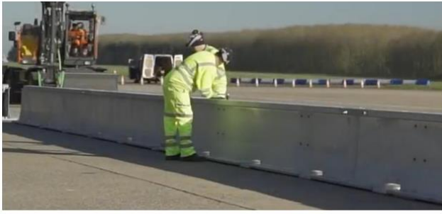
圖 3-24 便攜式的混凝土護欄及鋼護欄
