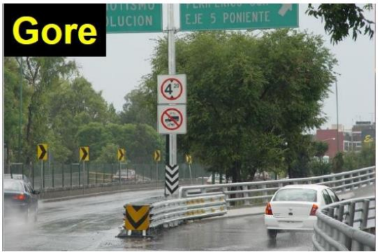
圖 3-19 護欄終端之緩撞設施
