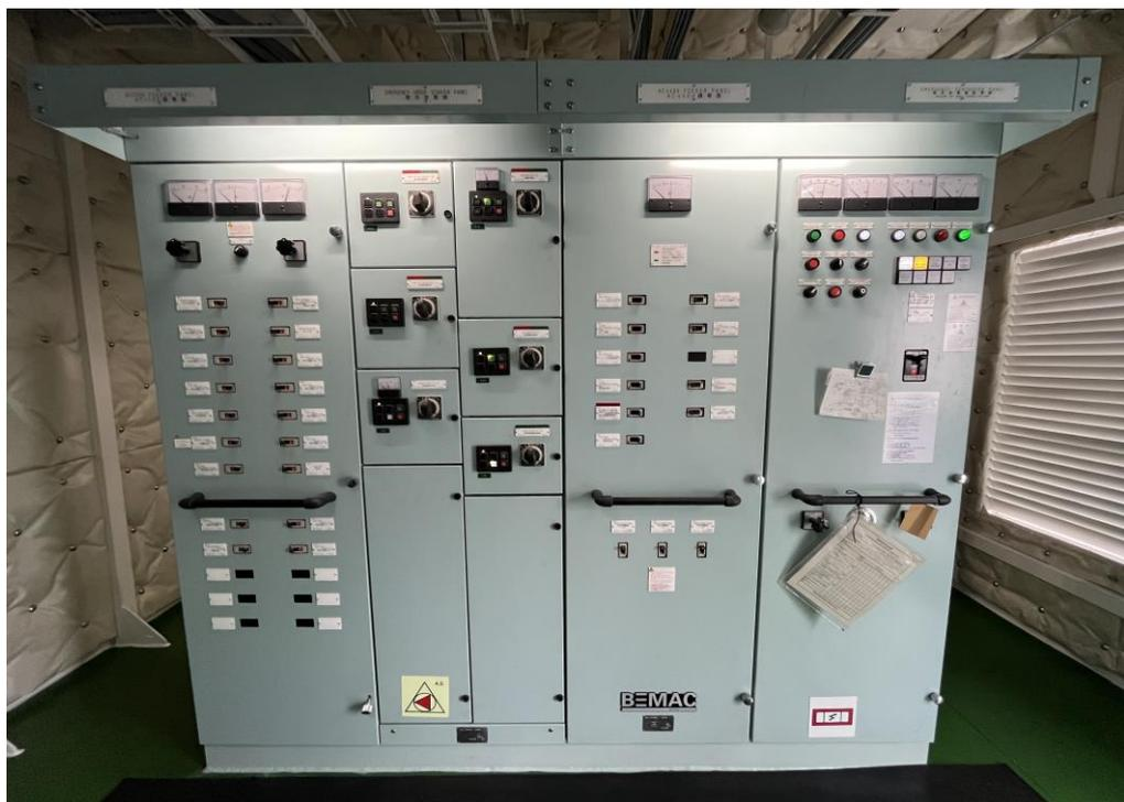
圖 25 緊急發電機配電盤
