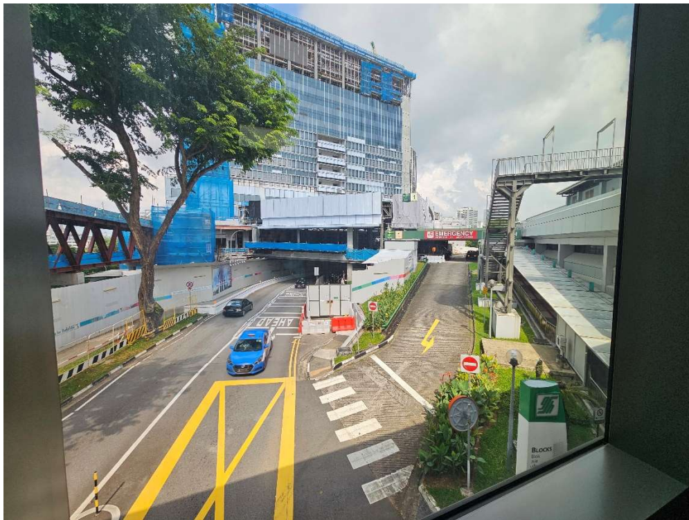
新建中的急診大樓，院區規劃各大樓二樓以天橋連接，為醫療人員及病人推送區域，一樓為來賓訪客區域，地下一樓為貨品運送區域
