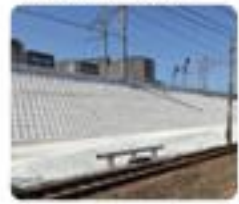
盛土区間の補強
