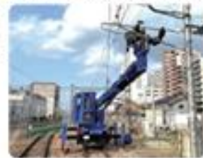
多機能鉄道重機
