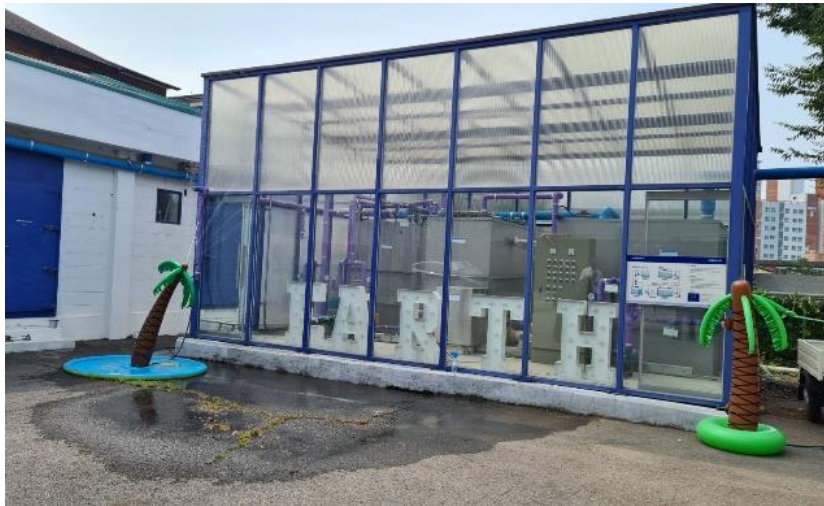
圖 12- 工廠雨水回收裝置
