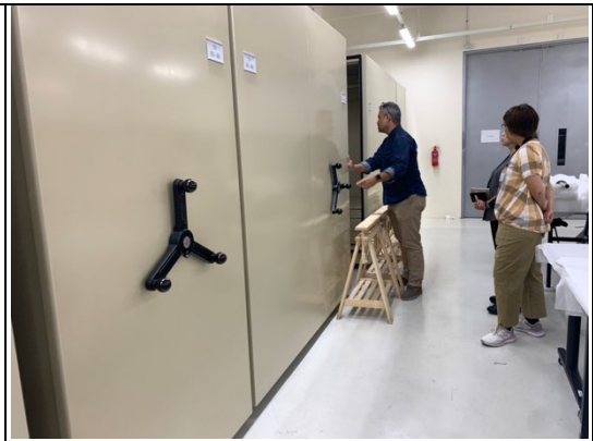
圖 51 織品庫房可移動防火氣密櫃架
