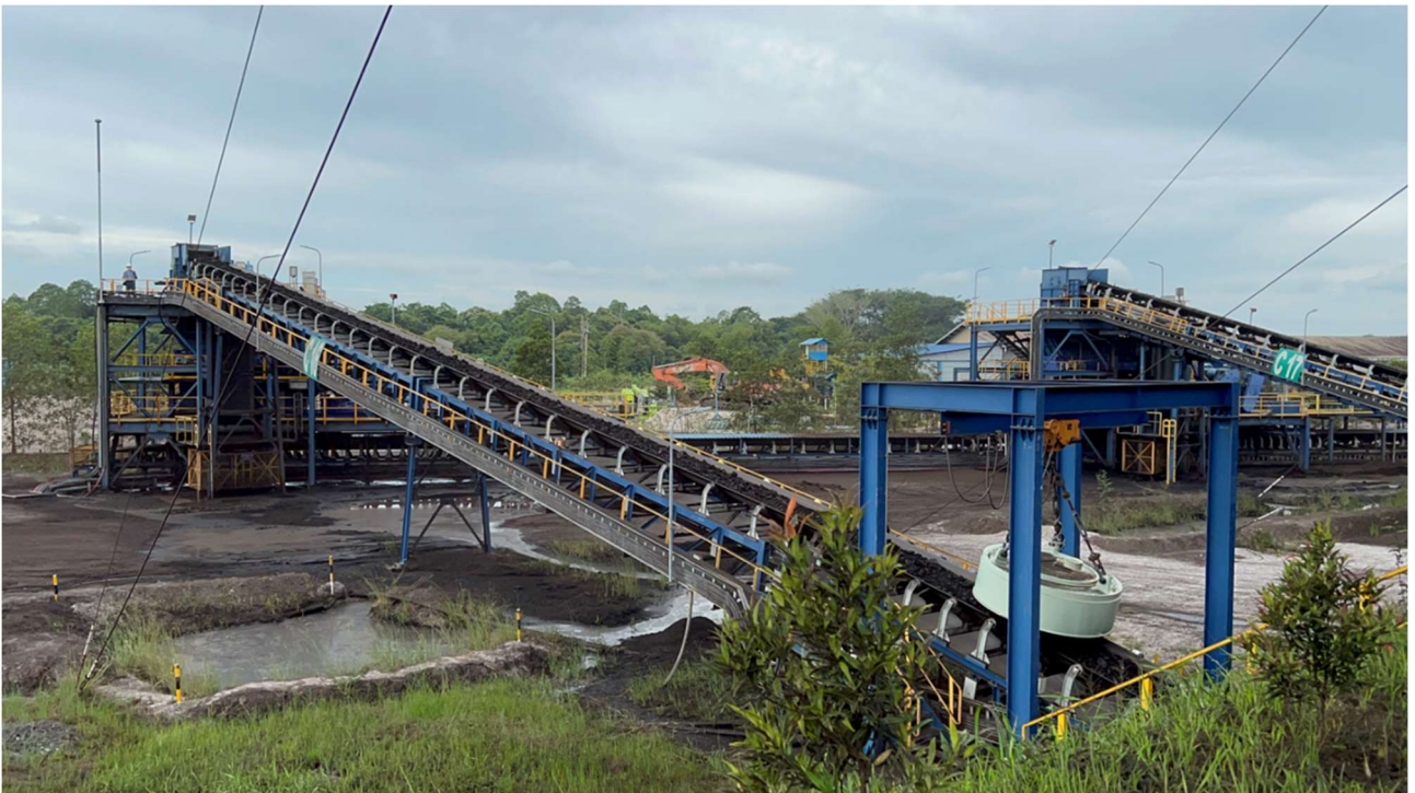
圖 14 碎煤傳送至 Jetty
