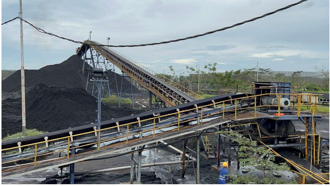
圖 39 Loa Kulu Jetty 之可售煤儲存場
