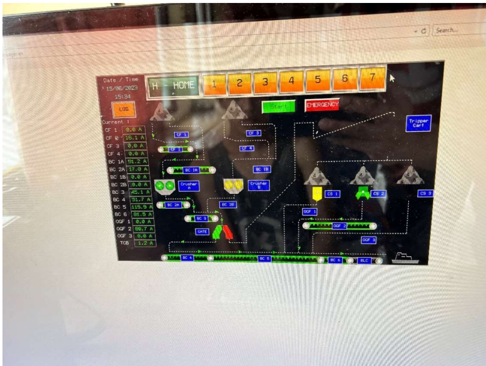
圖 42 Loa Kulu Jetty 的即時監控作業
