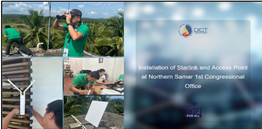
圖 28：菲律賓 DICT 分享於公共區域安裝 Starlink 設備及無線接取點（AP）
