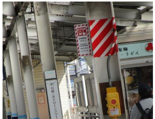
圖 3.6.6 東武鐵道川越站月台上緊急按鈕
