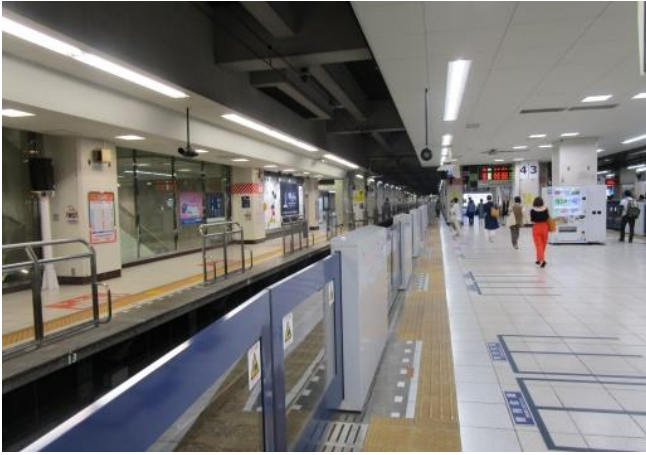
圖 3.6.3 東武鐵道池袋站月台門
