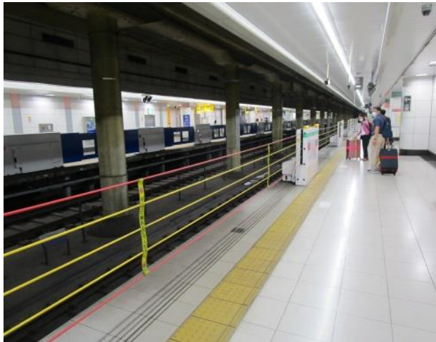
圖 3.6.1 JR 東日本成田機場第二航廈站月台門
