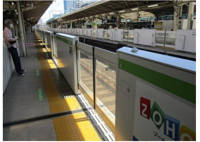
圖 3.6.4 西武鐵道池袋站月台門
