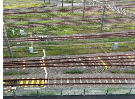
圖 3.4.27 水泥線槽淺埋穿軌
