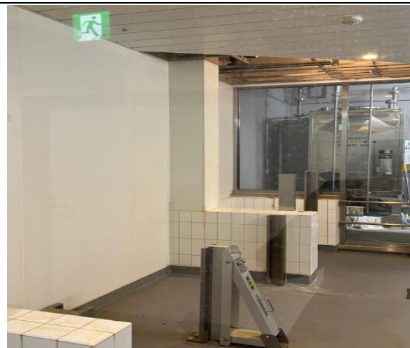
圖 3.4.11 模擬灑水實驗空間兼具隔水板組裝
