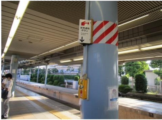
圖 3.6.7 西武鐵道本川越站月台上緊急按鈕
