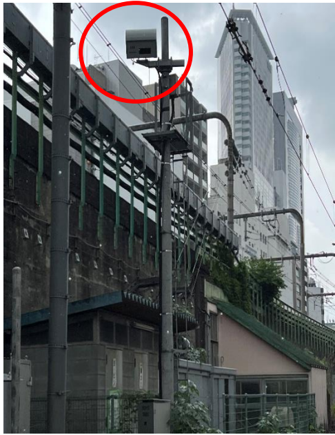
圖 3.3.8 代代木平交道 3D 雷達偵測
