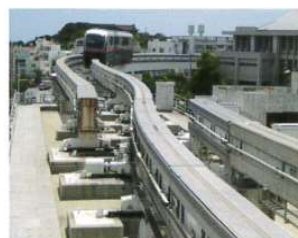
沖縄都市モノレール 株式会社殿納 モノレール分岐装置 Turnout Device of Straddle Type Monorail Track for Okinawa Urban Monorail, Inc.
