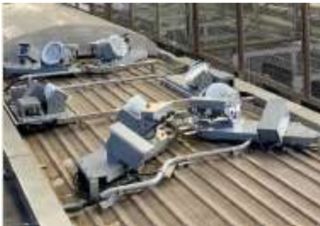
圖 78 軌道監控裝置
