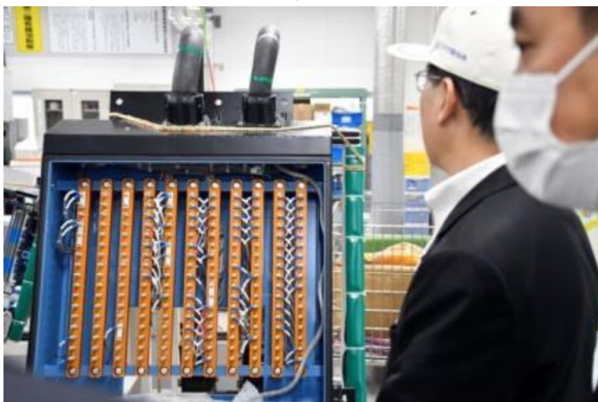
圖 4.4.2-7 本局人員檢驗接線箱裝配過程一
