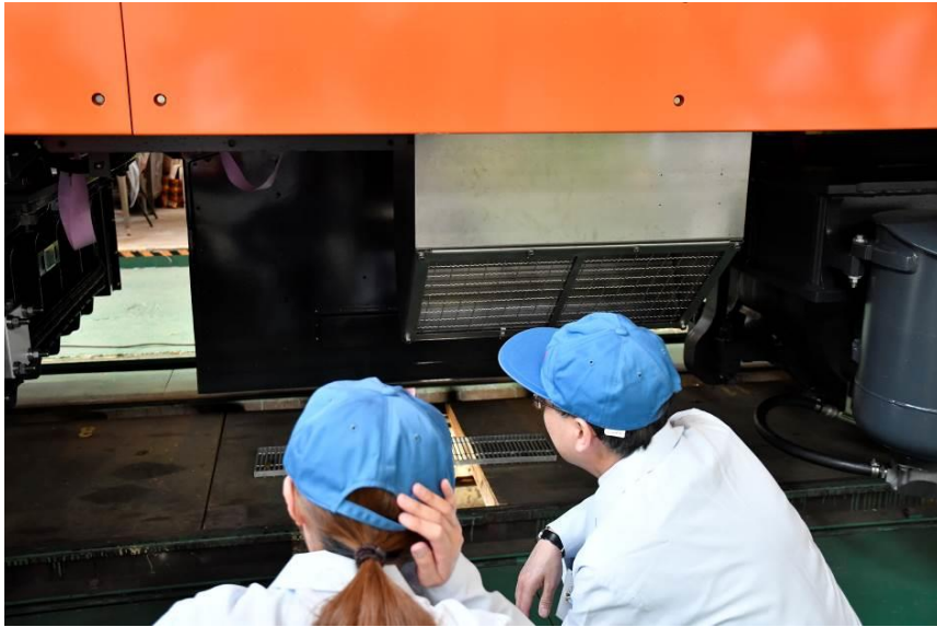
圖 4.5.1-8 冷卻系統排風口
