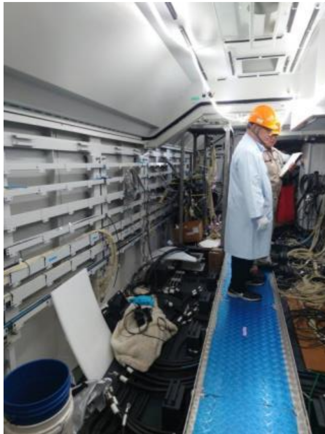
圖 4.2.2-2 測試時確認機械室內有無水入侵之跡象
