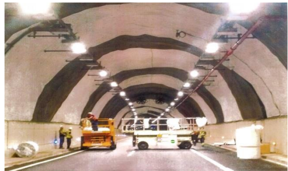
圖 3-7 防水膜施工
