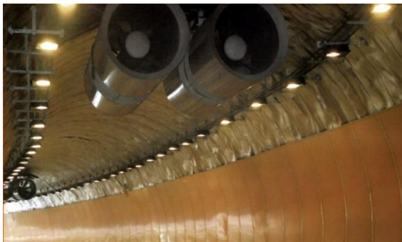
圖 3-6 防水膜施作於營運中隧道
