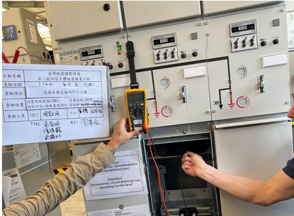
圖 3-12 絕緣電阻測試
