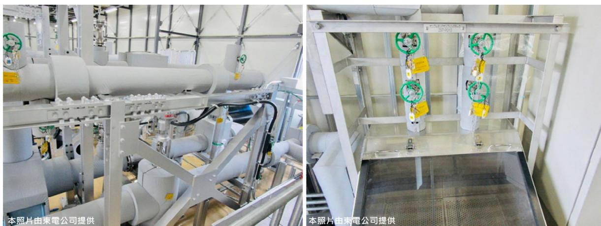
圖 11、ALPS 處理水循環取樣設施中的循環泵(左圖)與取樣設備(右圖)
