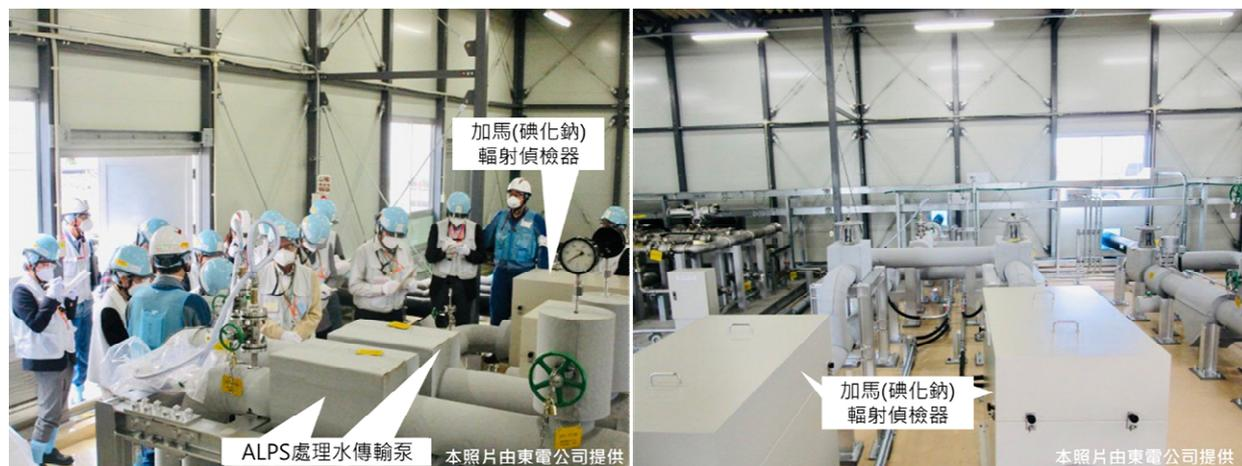
圖 12、傳輸設施中的 ALPS 處理水傳輸泵(左圖)與加馬輻射偵檢器(右圖)
