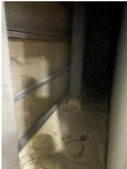
圖 33、倉庫採用 2 層建築牆面，牆面之間的空氣有助於保持倉內恆溫
