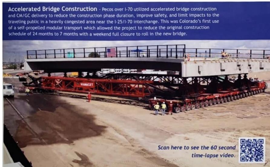
圖 3-27 自走式模組化運輸 (SPMT) 整跨橋梁
