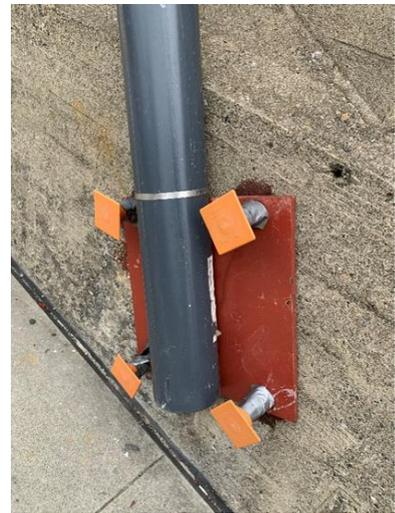
圖 4-11 金門大橋維修施工架錨固於大橋錨定座及突出螺栓保護措施
