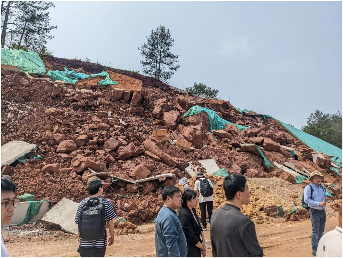
圖五、一新建高速公路工地旁的新鮮露頭。
