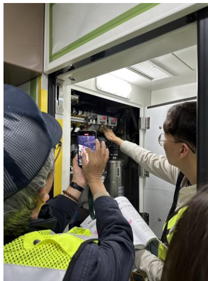
圖 18 廁所真空控制盤測試
