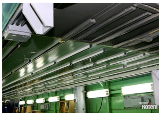
圖 108 不銹鋼車體進行車底防腐蝕及防噪塗裝
