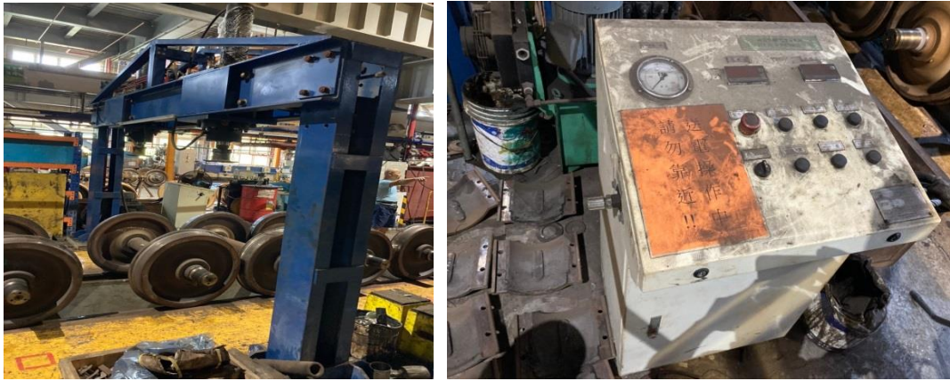
圖 47 富岡基地設有兩台靜負荷測試台 2
