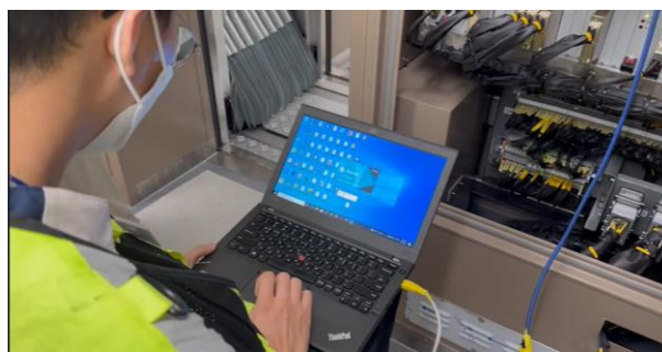
圖 16 使用維修電腦確認攝影機影像串流功能
