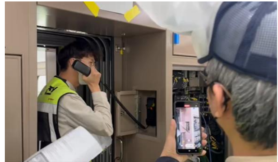
圖 15 輔助通訊面板(ACP)測試
