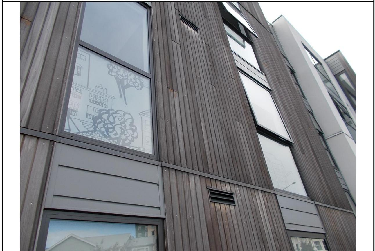
圖 189-在 Karo Drive 的雪松外牆細節、通風口及內部的窗戶塗鴉
