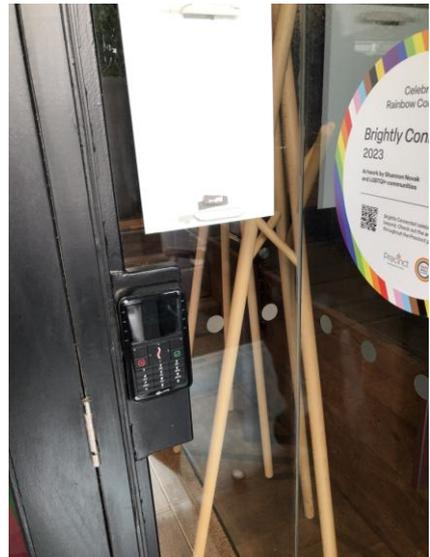
圖 147-入口的電子門禁系統
