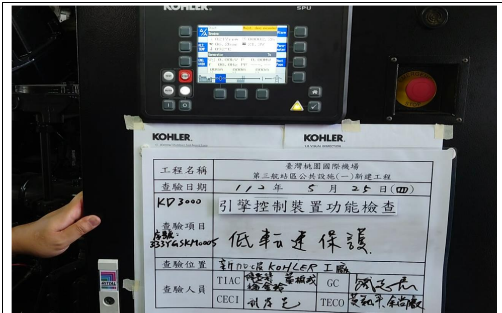
圖 3-52 引擎低轉速運轉保護
