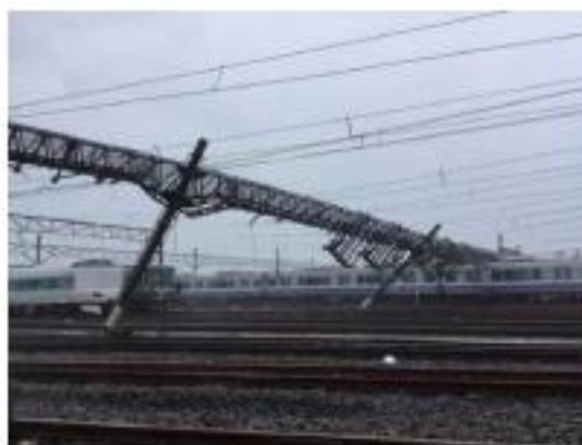
吹田総合車両所 日根野支所 強風による電化柱倒壊 (2018年9月 台風21号)
