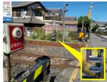
踏切への障害物検知装置の整備
