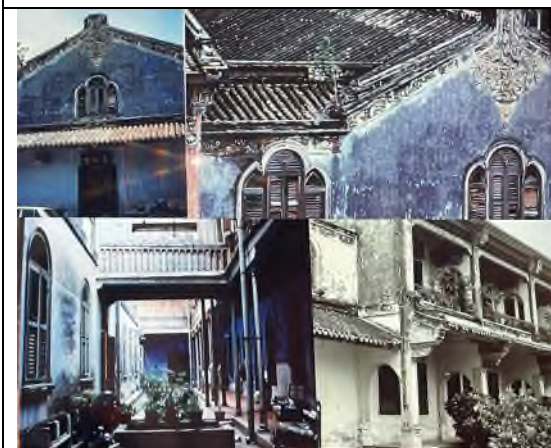
張弼士故居修復前的外觀（照片來源：故居簡報資料）
