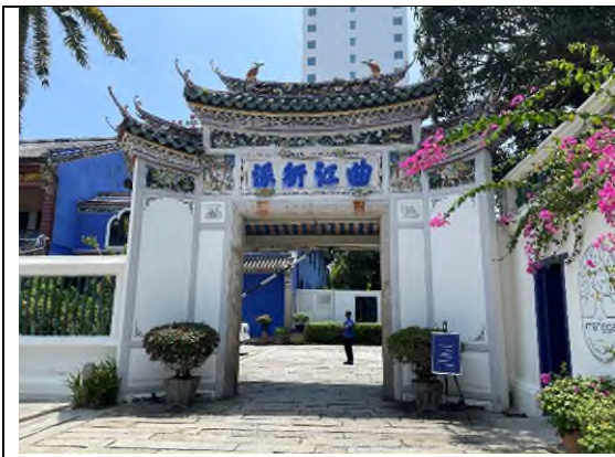
張弼士故居戶外牌樓，修復後仍保持中國園林式的外觀。
