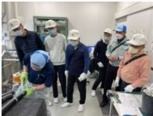
圖 4.2.10 跳線外皮卸除作業
