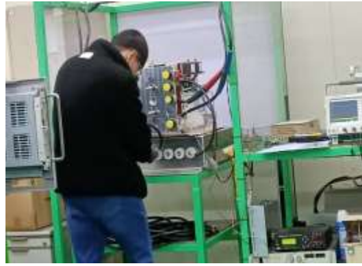
圖 4.1.12 進行設備突波檢查及測試
