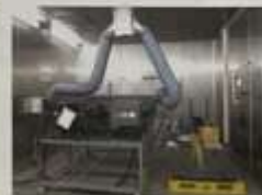
Test Equipment for Air Conditioning 測試設備 用於空調
