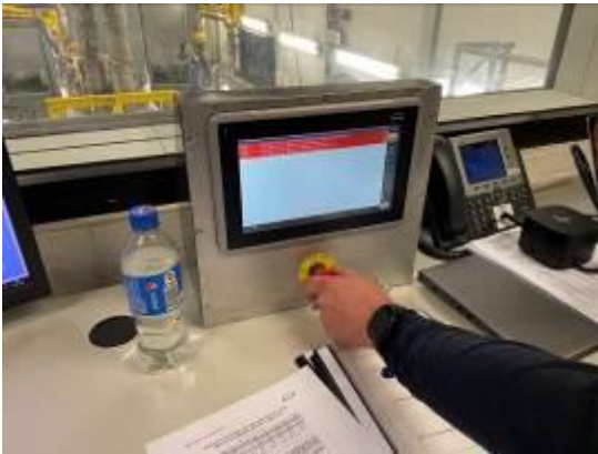
圖 11、圖 12.緊急跳脫測試
