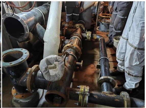
壓艙水泵間管路製作
