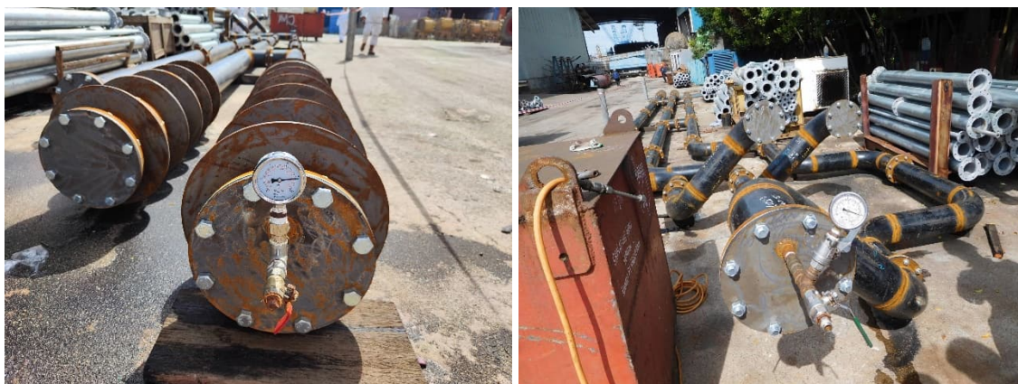
壓艙水管路試壓
