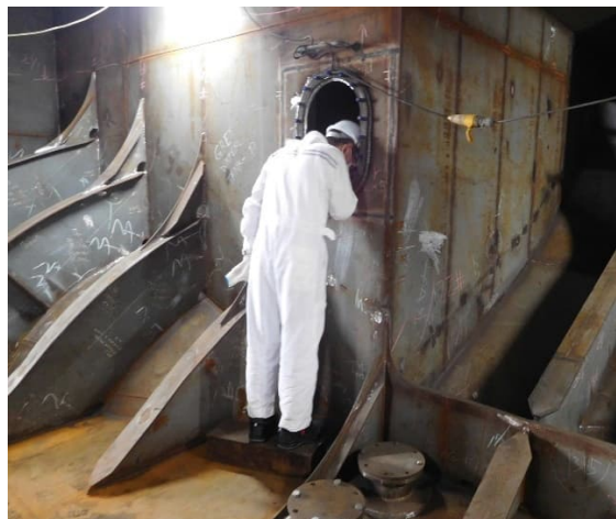
機艙油櫃內部檢查
