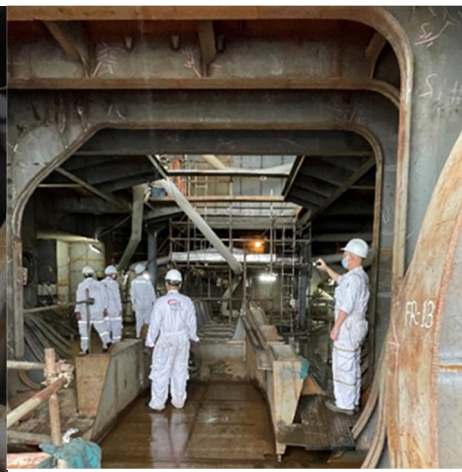
機艙製作中結構檢查
