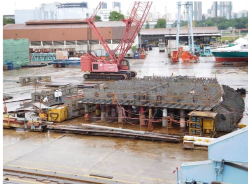
貨油艙段B05 Block 製作中
