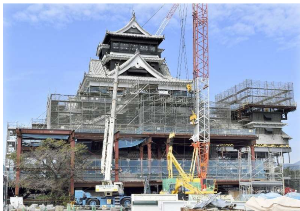
圖 10. 熊本城天守閣修復工程
