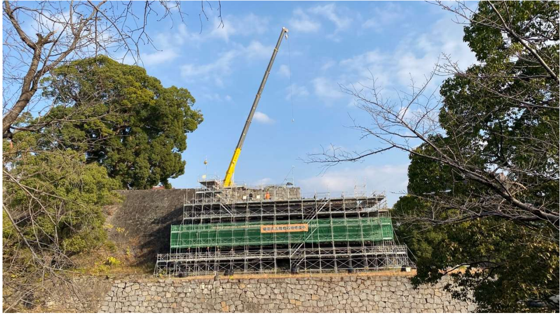
圖 11. 熊本城城牆修復工程
