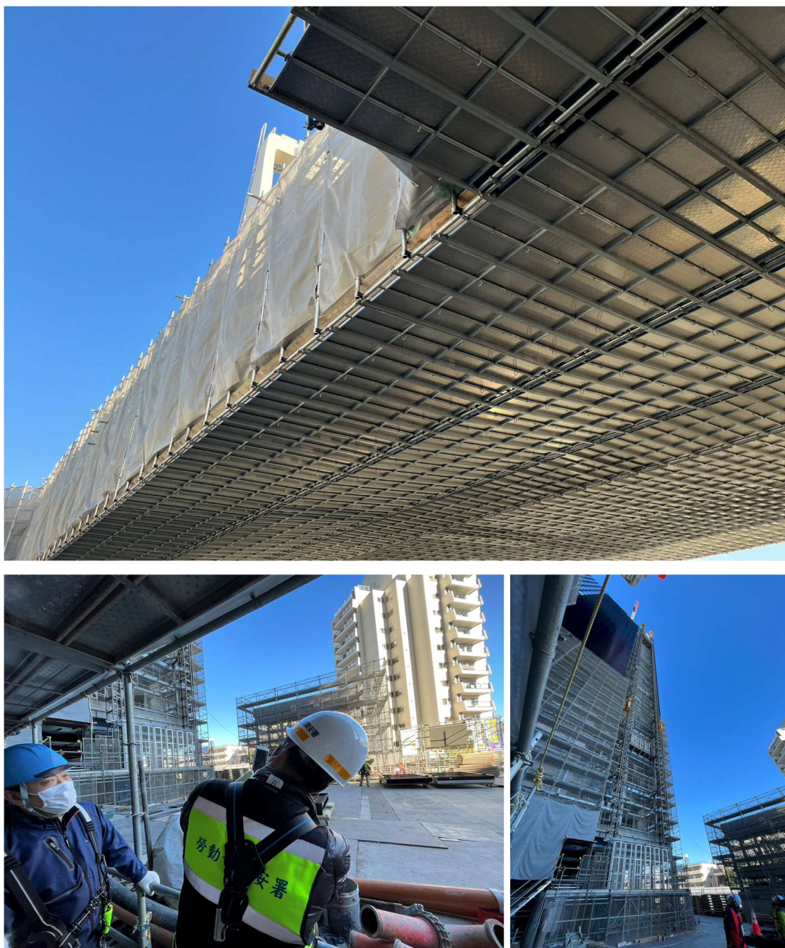
圖 19. 倒吊系統架補修橋梁以及爬升式系統施工架
