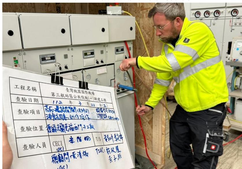
圖 3-20 機械功能操作測試
