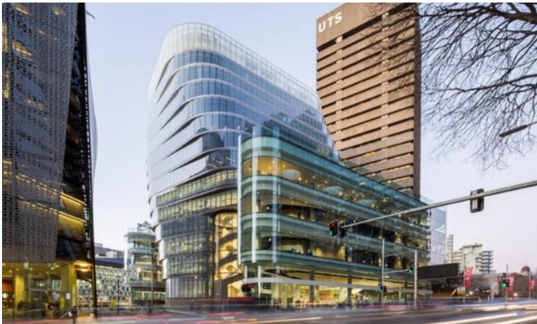
UTS Central 2 號樓外觀
