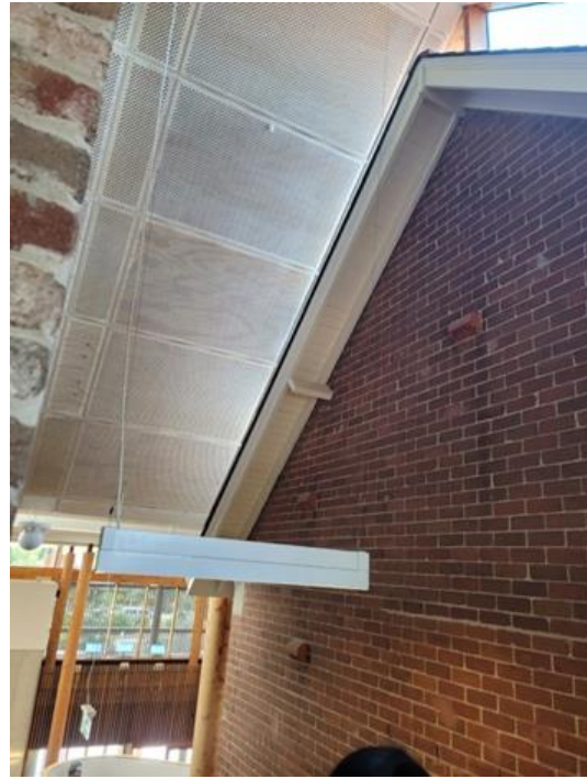
建築師利用不同材質及形式區別新舊建築的屋頂
