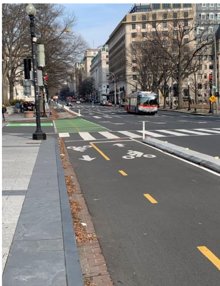
圖 3.5 自行車專用道 1(實體分隔)
