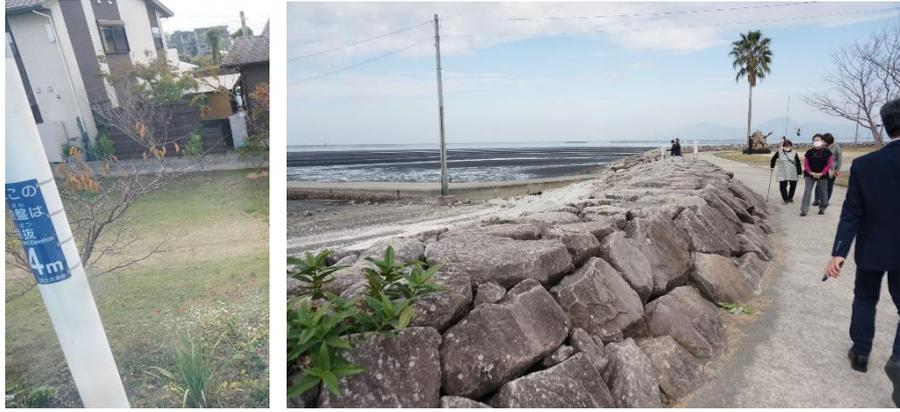
圖 75 降低高度的海堤設施與電線杆上地表高程標示
