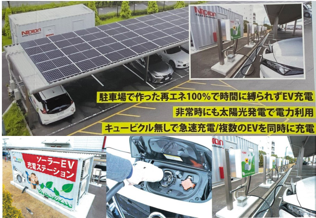
圖 30、Nipron 公司發表之太陽能停車棚及電動車充電系統
