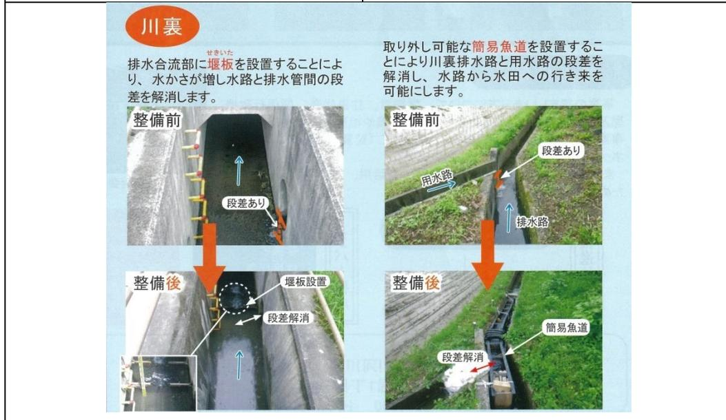
圖18 簡易設施（堰板及簡易魚道）消除高低落差
