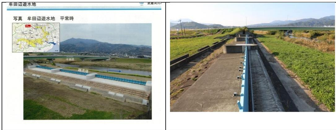
圖83 遊水地溢流口設施平時情形
