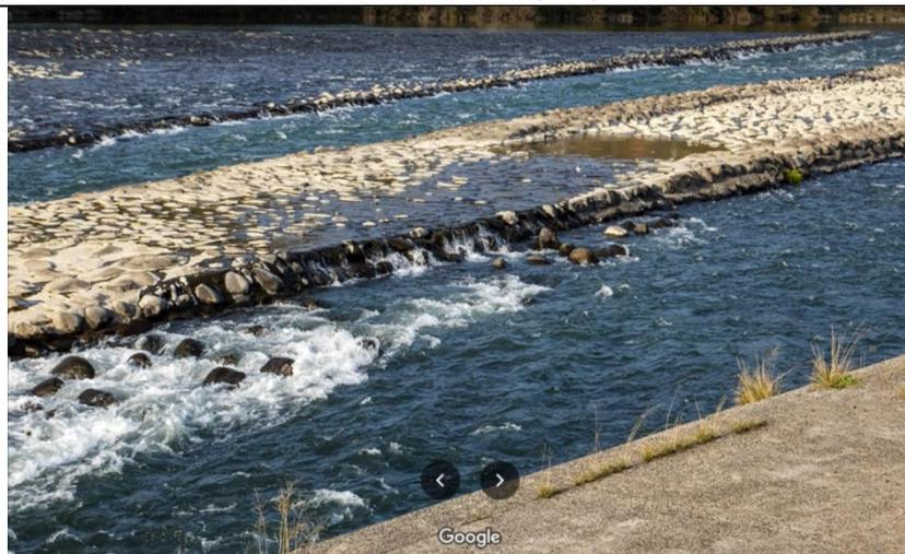
圖54 南舟通阻力側抬高，並緩坡及鋪石消能 (google網路相片)
