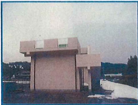
膜浸漬槽外観
