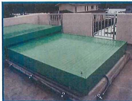
膜浸漬槽上部
