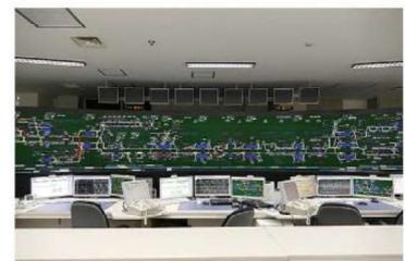
圖4-4 京三公司列車集中控制裝置及列車運行管理裝置實地探訪照片
